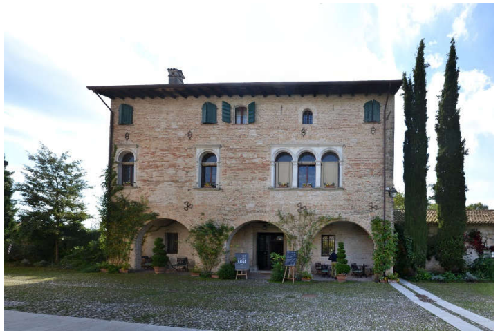
PALAZZO AGRICOLA (SEDE DELLA CAFFETTERIA DEL BORGO)
