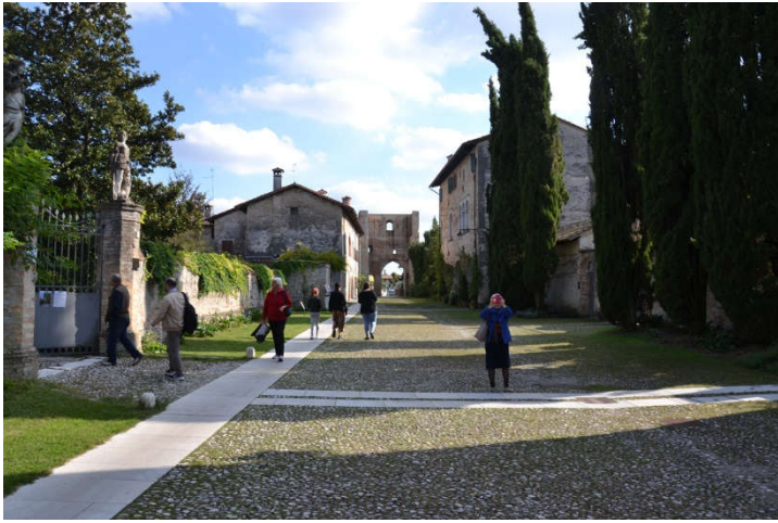
CORTE INTERNA DI ACCESSO AL CASTELLO (VISTA VERSO LA TORRE SUD)
