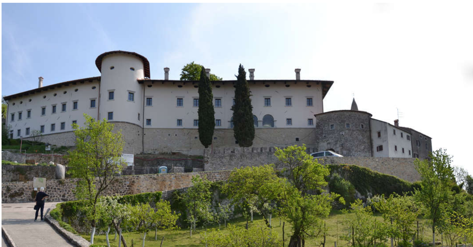
IL CASTELLO NEL 2018, QUASI COMPLETATO
