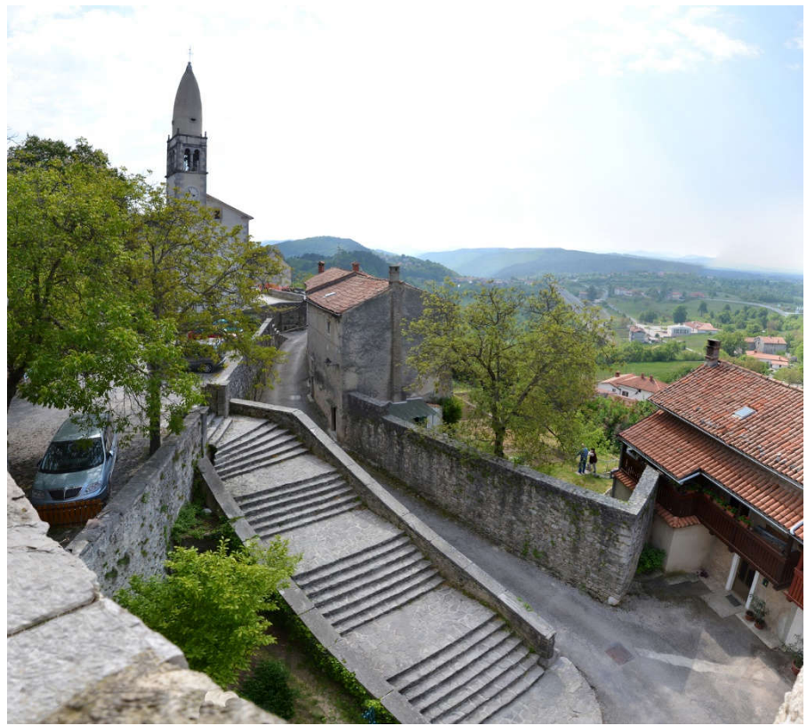
SCALA D'ACCESSO AL SAGRATO CON VISTA PANORAMICA
