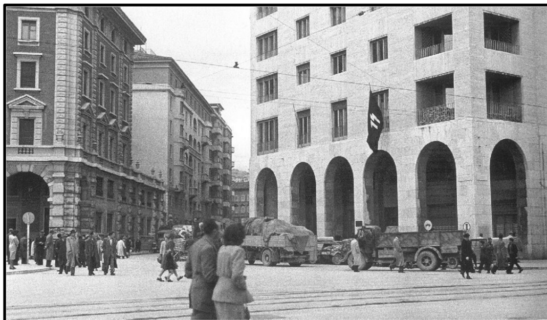
La sede delle SS a Trieste in piazza Oberdan
