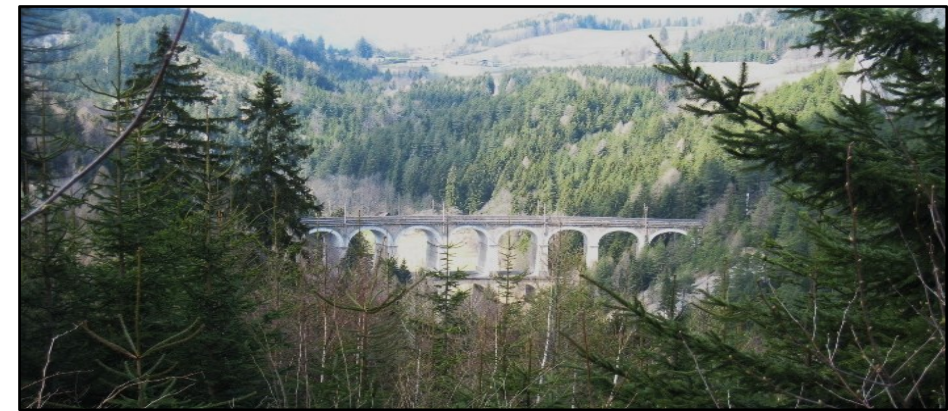
Viadotto al Semmering
