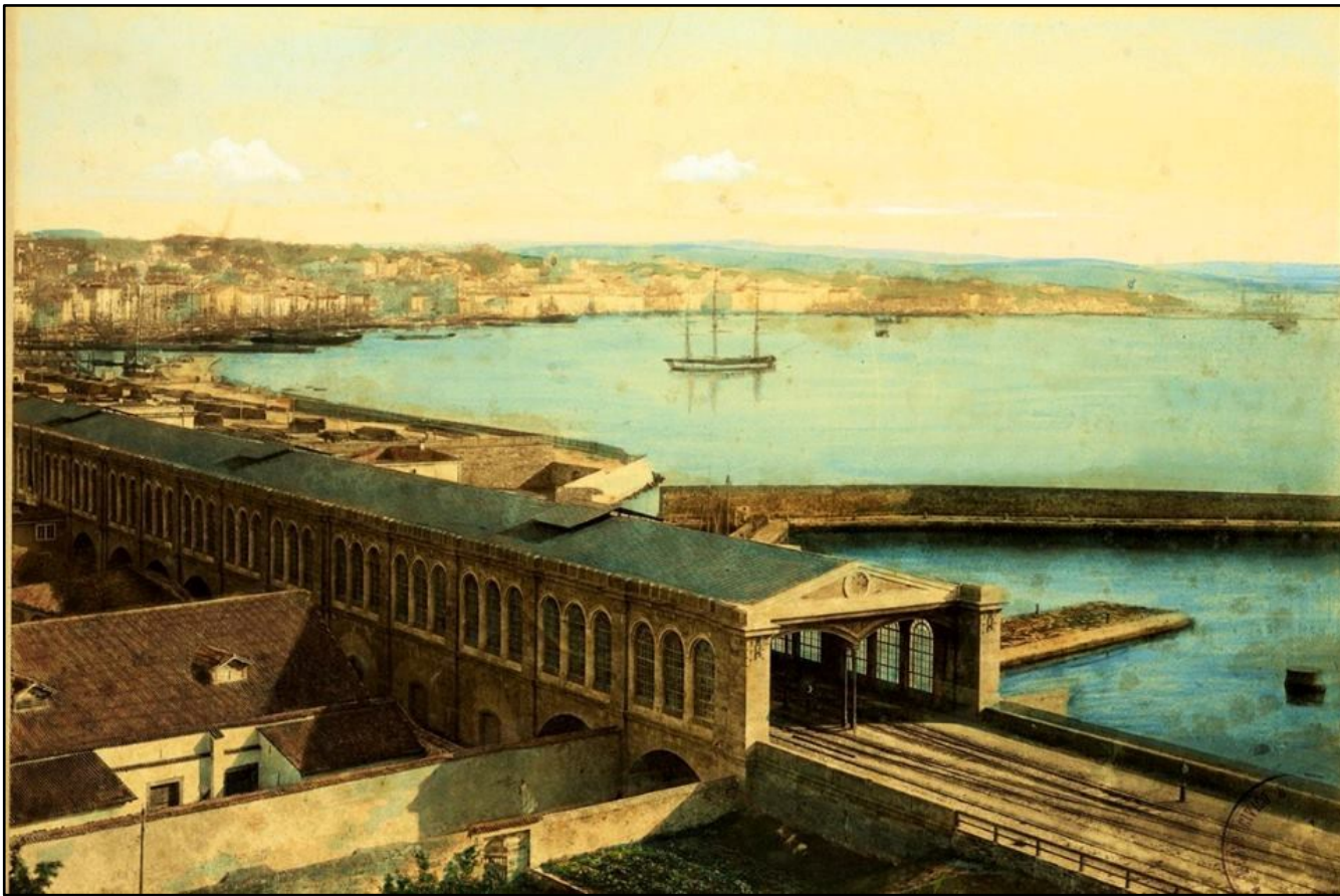
Il viadotto della prima stazione
