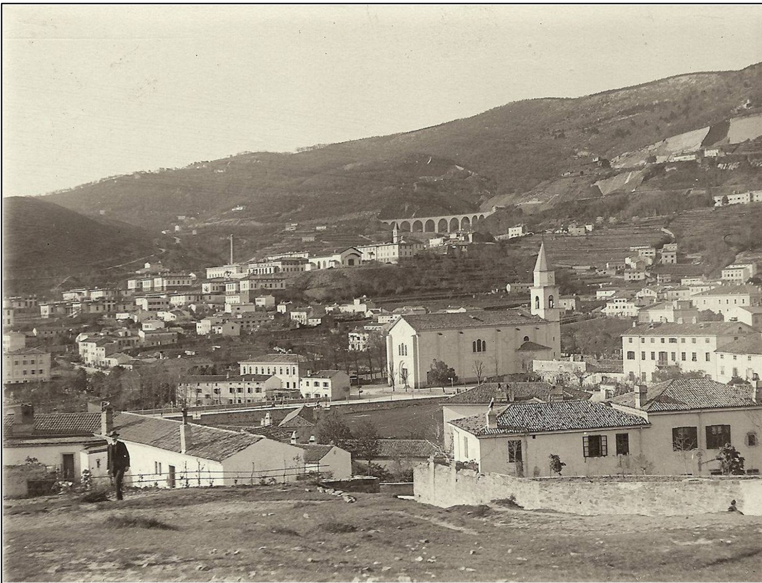
Il viadotto di Guardiella
