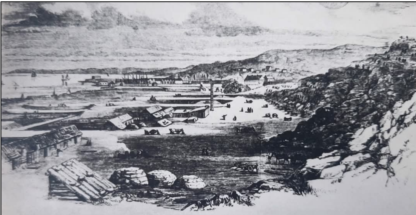
Preparazione del terreno su cui sorgerà l'edificio delle stazione
