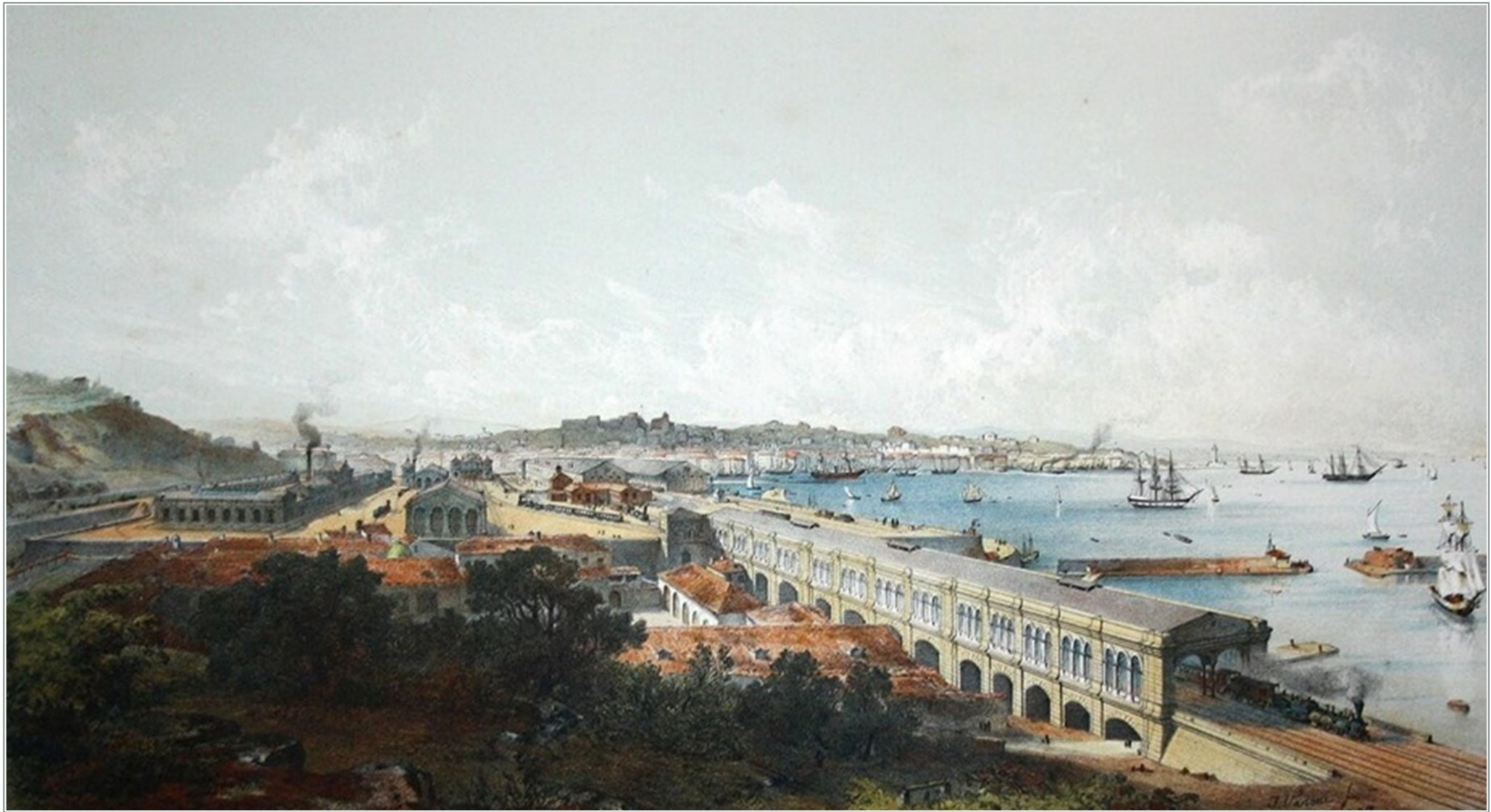
Il viadotto della prima stazione
