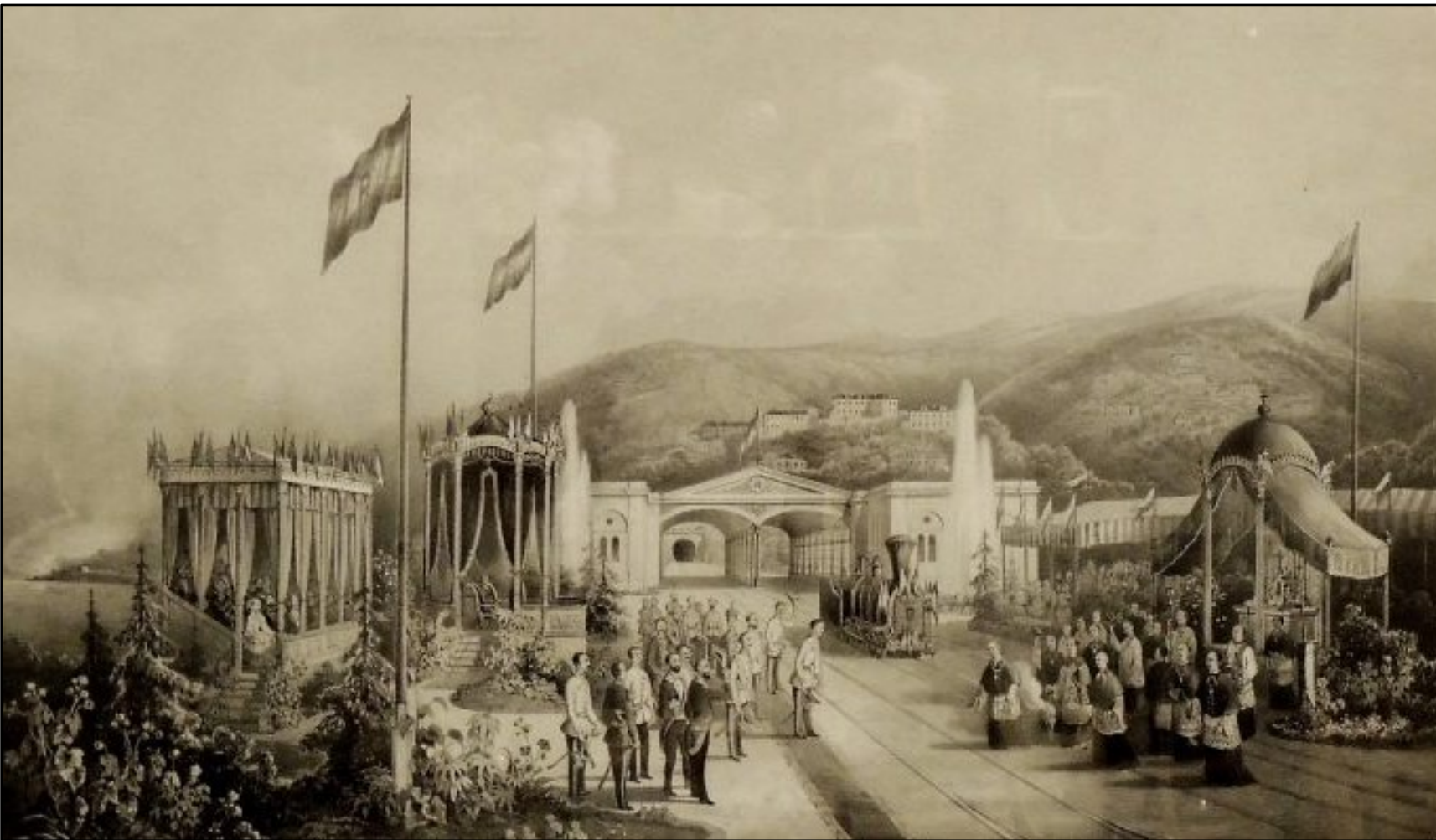
Inaugurazione della stazione della Ferrovia Meridionale
